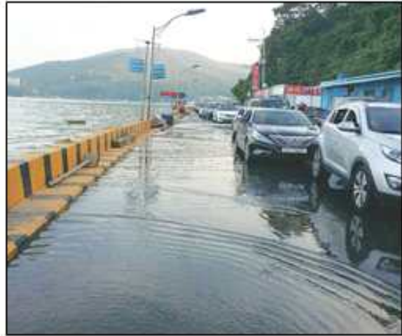
인천 중구 무의도 일대 도로 침수
